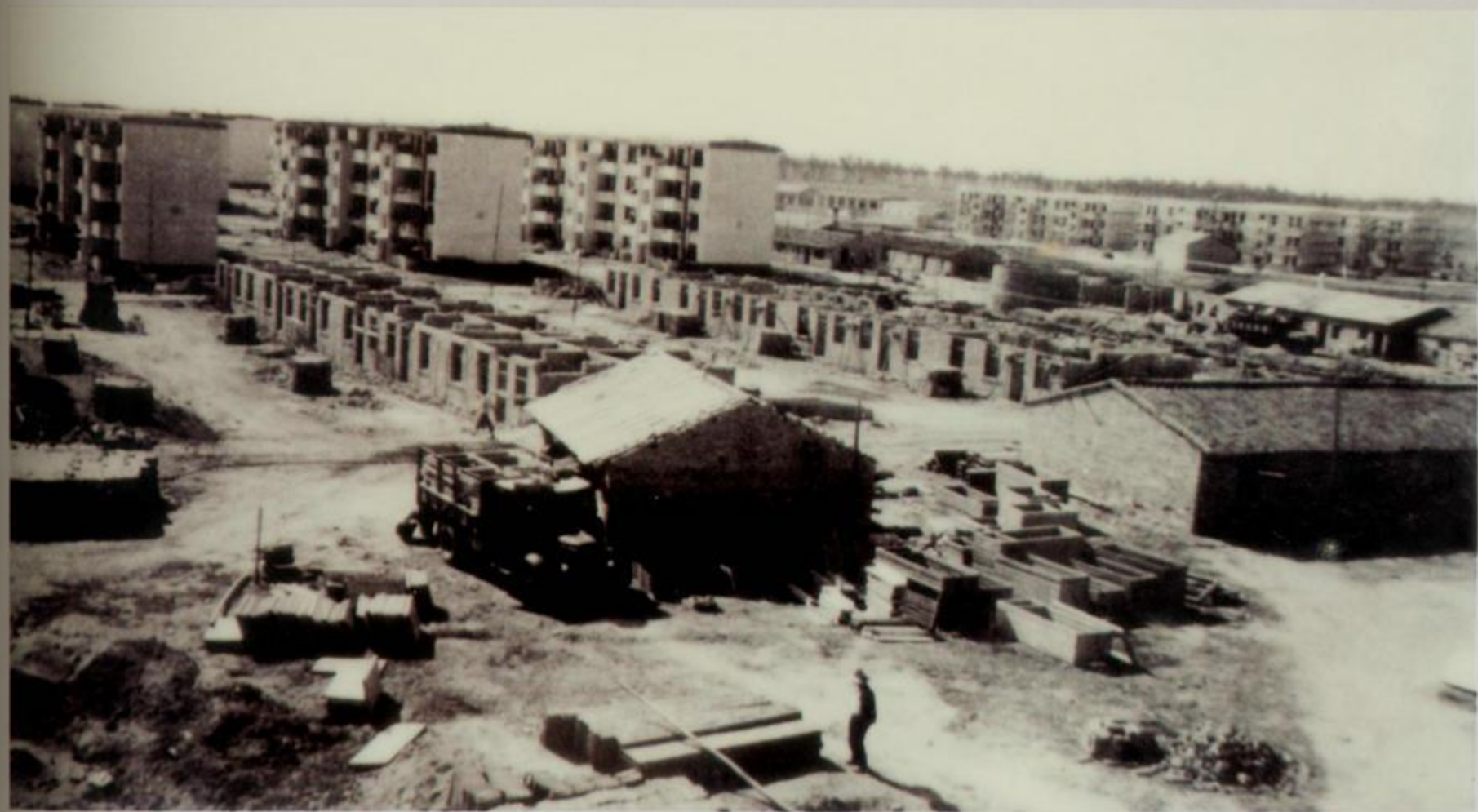
难民楼建筑工地
