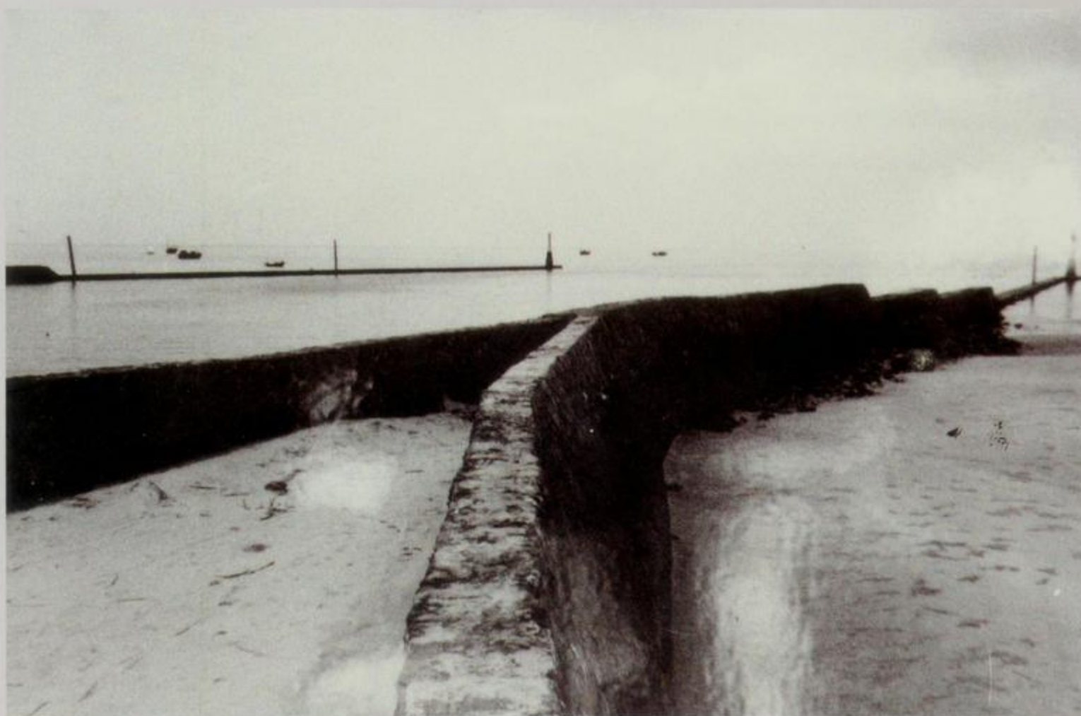
建设中的海堤
