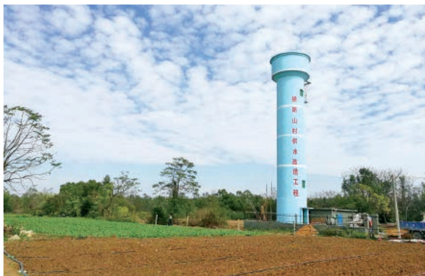
2017 年 12 月,平阳镇横路山村供水改造工程落成
