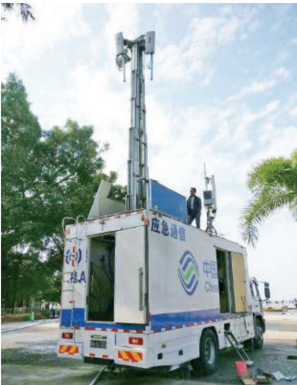
2017年,中国移动北海分公司通信保障施工现场 中国移动北海分公司 供
