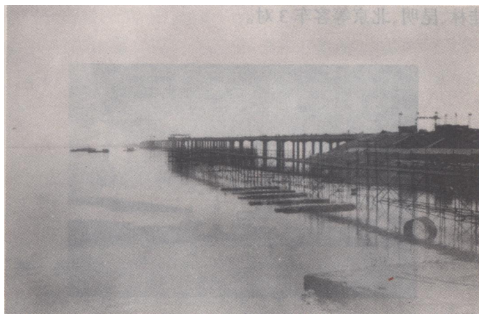
铁山港跨海大桥
