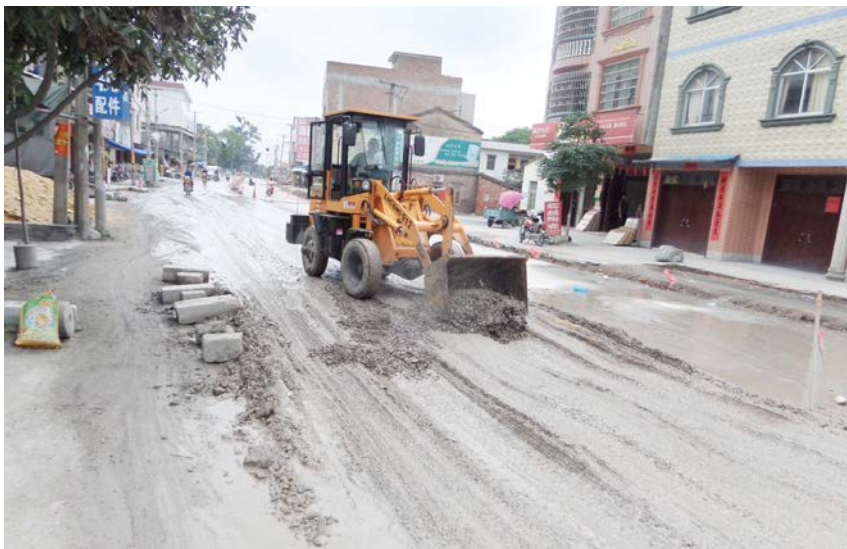
2015年5月7日,闸口镇组织安排修补325国道
