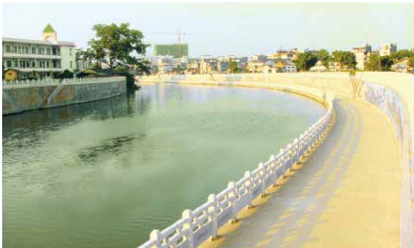
贷款项目西门江工程
