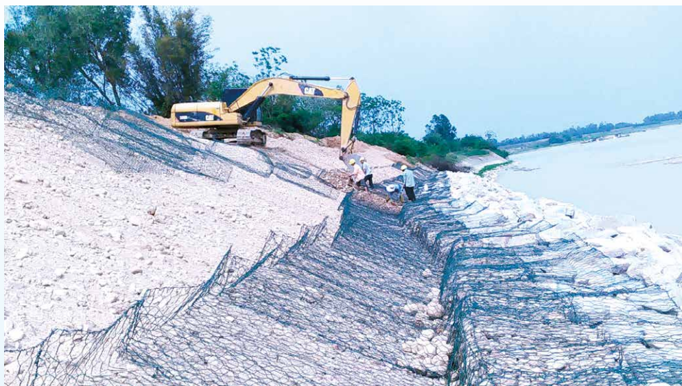
2015年开工建设的南流江防洪治理工程 县水利局 供
