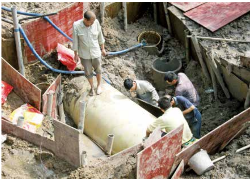
2015 年 9 月华泽水务公司员工全力抢修输水管线现场 (县市政局 供)
