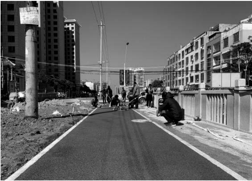
2020年9月26日,城东水道自行车道面层浇筑透水混凝土。
