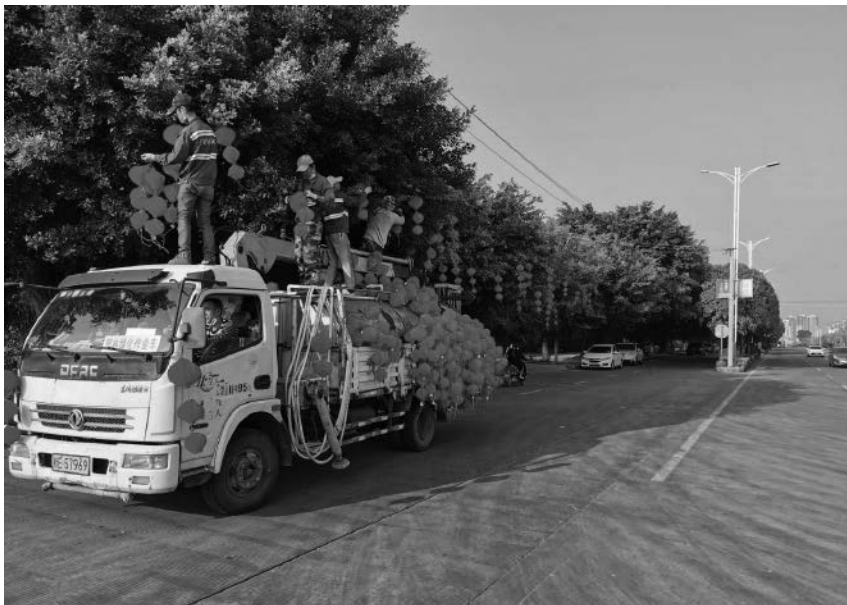
2020年1月5日,园林工人在合浦县城主干道路摆放花卉和装挂灯笼美化城市。 (县住建局供)
