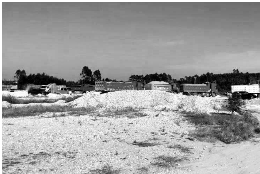
2020年10月,总投资6.55亿元的合浦县水系连通及农村水系综合整治工程项目全面开工。(廖仕成 金星瑜供)
