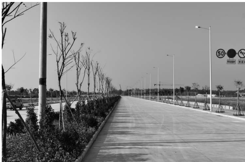
2020年12月30日,海发路竣工。
