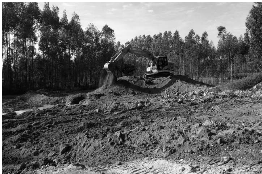
2020 年 11 月 11 日,县自然资源局组织相关部门对沙岗镇土地违法图斑进行拆除。(县自然资源局供)
