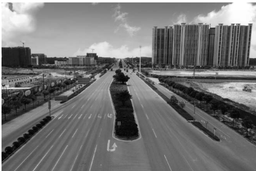
2020年11月28日,外东环路(南段)道路中分带、侧分带绿化提升工程全面完成。 (县住建局供)
