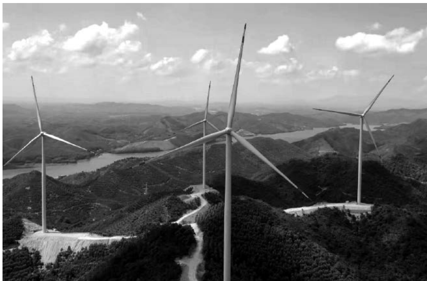
2020 年 12 月 11 日, 曲樟风电场最后一台风机吊装完成。(曲樟乡政府供)
