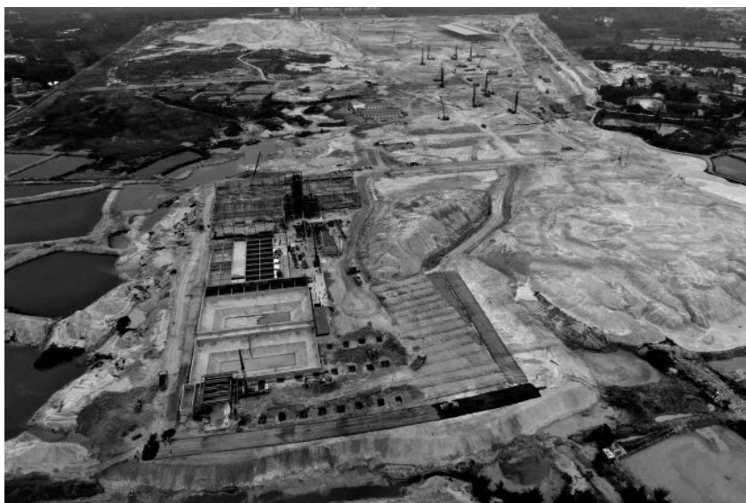
2020 年 11 月 15 日,广西新福兴硅科技产业园现场施工图。
