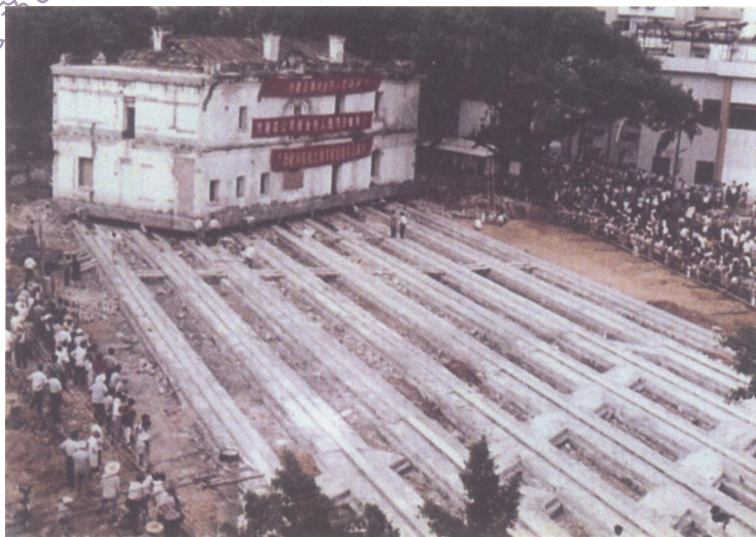
▲图 1-13 英国领事馆旧址平移现场
