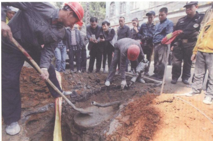
▲图 1-18 北海市中山路管道改道现场
