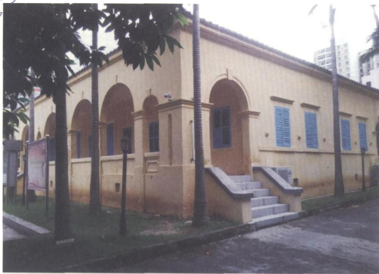
▲图 7-22 德国信义会教会楼旧址侧面
