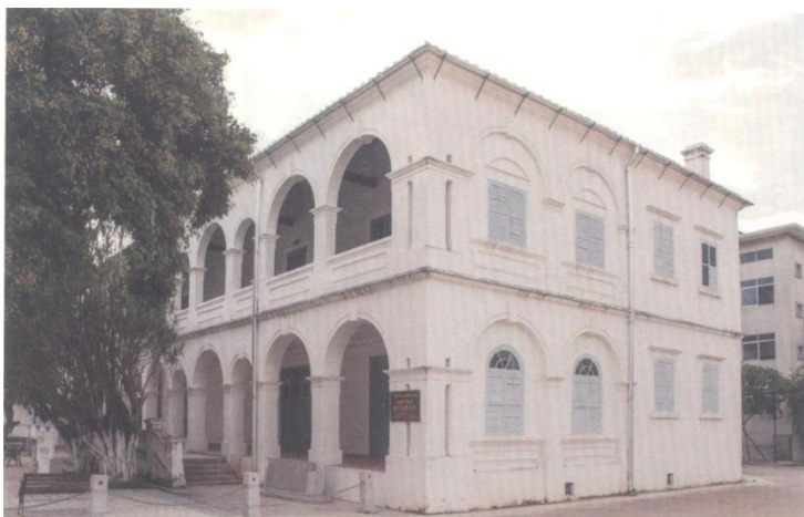
▲图 5-11 维修后的北海普仁医院旧址医生楼
