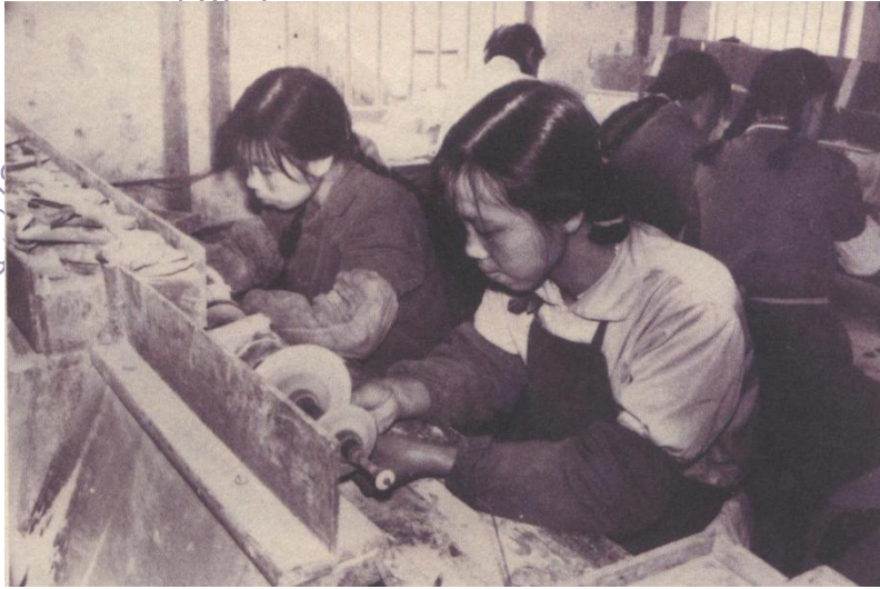
■精心打磨。这种“一机多轮式”打磨机由北海工艺美术厂与北海风机厂联合研制，属国内首创，功效提高了一倍，产品质量也大大提高（图片由陈佐提供）
